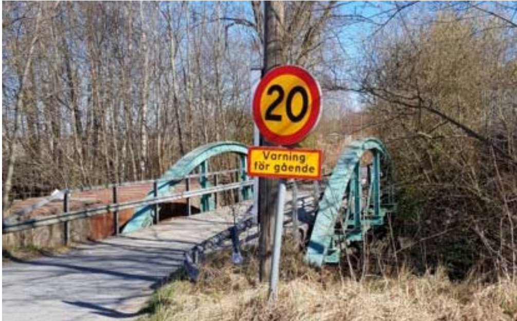
Bron över Lärjeån (Foto: Sweco)
